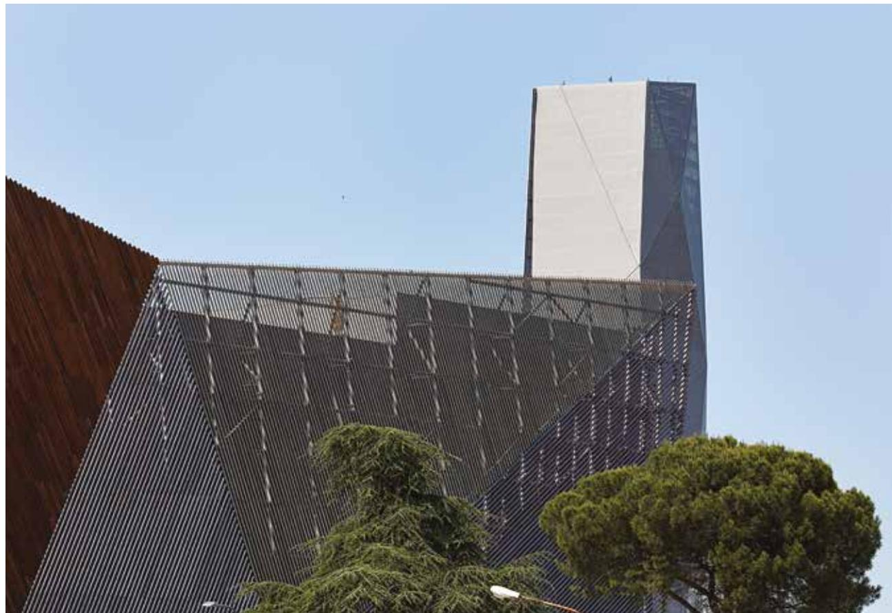
A fachada suspensa em estrutura metálica em balanço segue a estética Razzle Dazzle de camuflagem, com translucidez gerada de acordo com a posição do observador.
